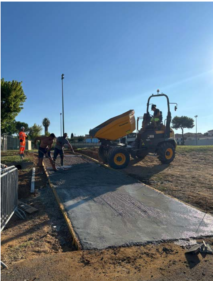
Rampe d'accès école maternelle
