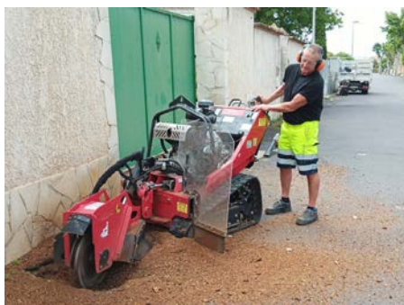
Élimination des arbres malades Avenue de la Condamine
