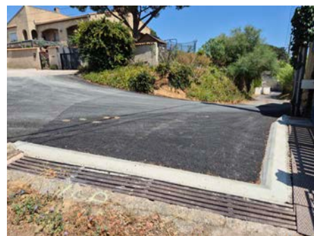
Remise en forme de la voirie Impasse des Mimosas
