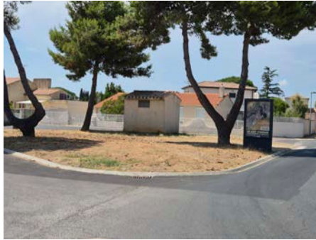
Réfection voirie et abattage d'un pin ayant endommagé la route
