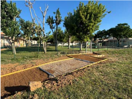
Création d'une rampe d'accès entrée école maternelle
