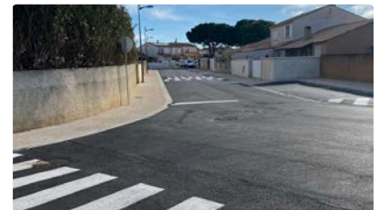
Réfection du quartier du Mas de l'Ecluse
