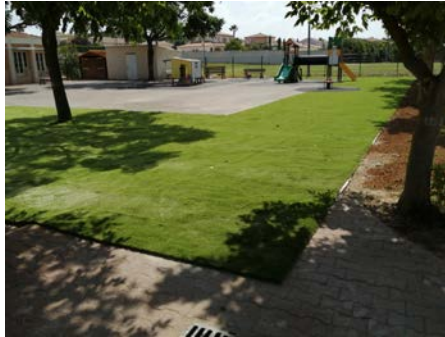
Travaux estivaux cours maternelle
