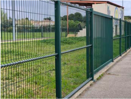
Réfection du grillage du stade suite à dégradations volontaires et pose d'un portail d'accès
