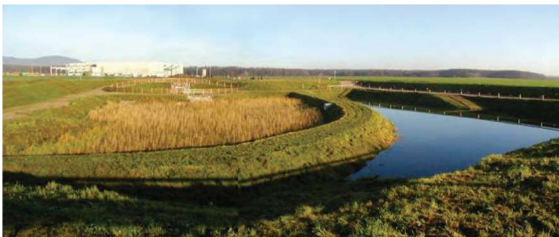
FILTRES PLANT S, AVEC BASSIN PAYSAG EN SORTIE DAMBACH LA VILLE (BAS-RHIN), ZONE D'ACTIVIT
