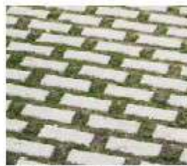
Pavage en béton avec ouvertures de drainage
